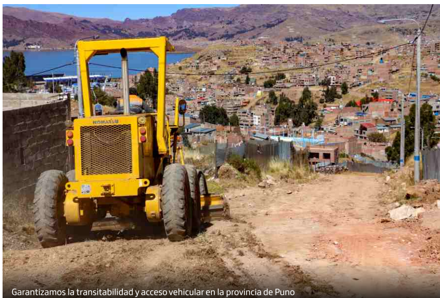
Garantizamos la transitabilidad y acceso vehicular en la provincia de Puno
