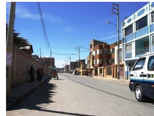
Edificaciones de concreto en Av. principal
